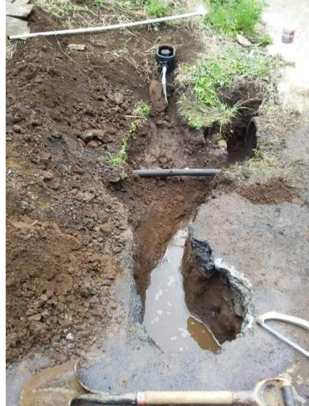
5. Fuga en medidor en el sector de Buena Vista, vehículo se estaciono encima provocando que el tubo se quebrará y ocasionando fuga.
