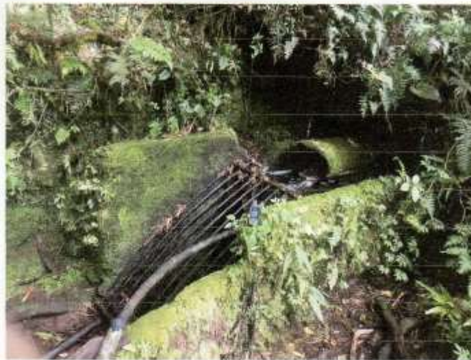
Foto N° 2. Rejilla (Punto GPS N° 379 y 7).
