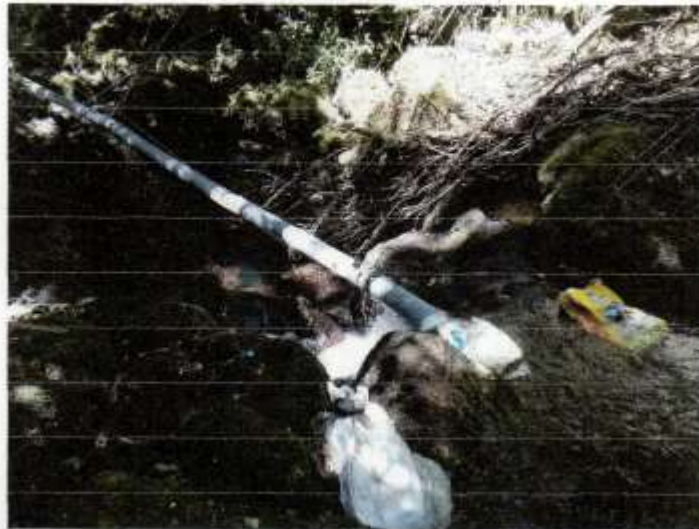
Foto N° 1. Captación en Río Segundo (Punto GPS N° 10).
