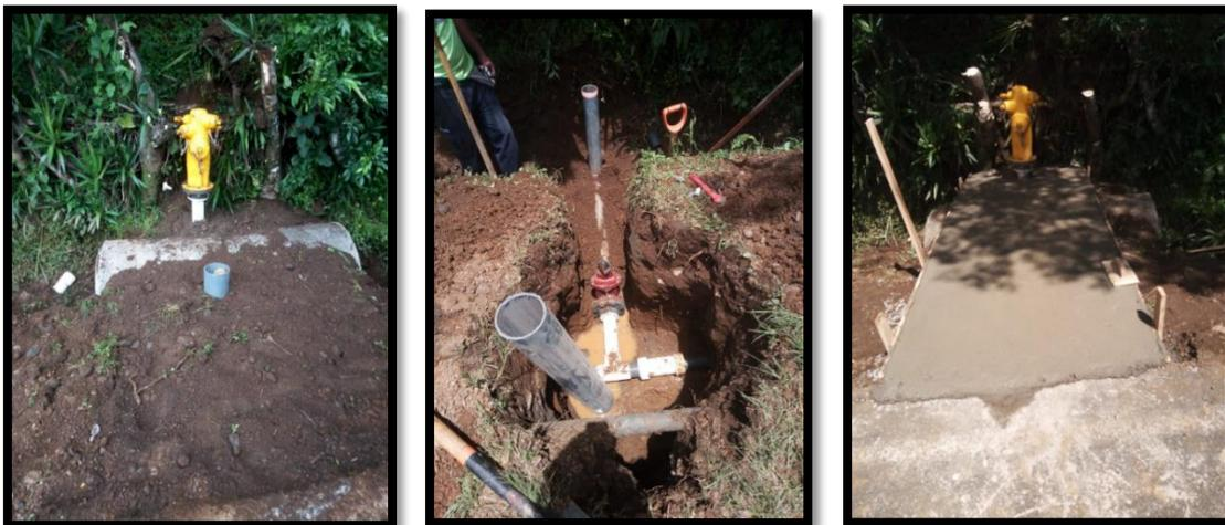
*Figura 12. Evidencia de la colocación de hidrantes*
